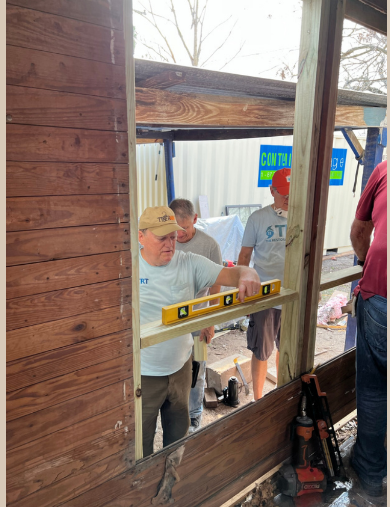
DAN FRAMING OUT A NEW WINDOW
